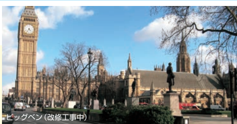
ビッグベン(改修工事中)
